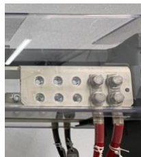
Fin de la batterie cosse de câble et barre omnibus de la centrale terminaison Lug
